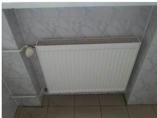
Zdj.: grzejnik stalowy płytowy zlokalizowany w pomieszczeniu WC.
