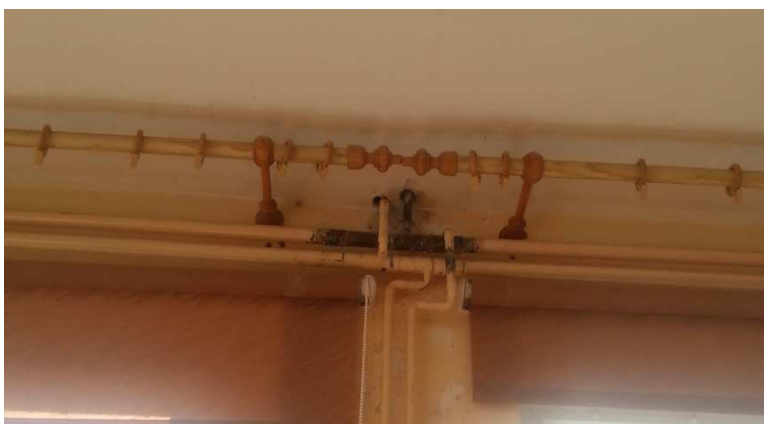
Zdj.: nieocieplone przewody C.O.
