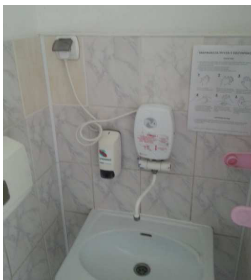
Zdj.: umywalka wyposażona w elektryczny przepływowy podgrzewacz wody
