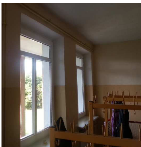
Zdj.: okna bez nawietrzników
