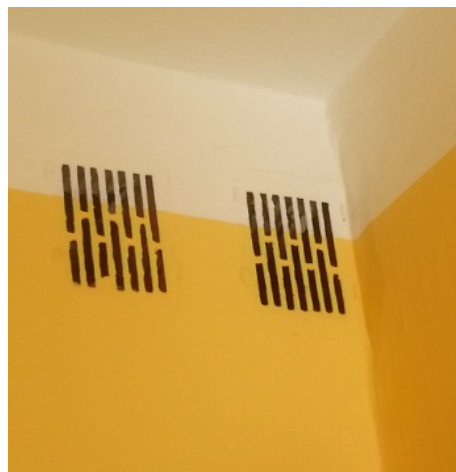
Zdj.: kratka wywiewna wentylacji grawitacyjnej w sali lekcyjnej
