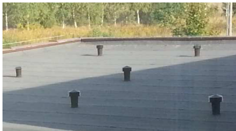
Zdj.: kominki wentylujące pokrycie dachu
