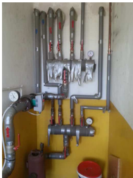
Zdj.: rozdzielacze na przewodach C.O.
