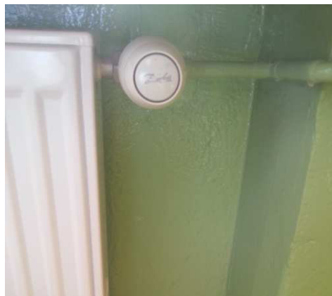
Zdj.: głowica termostatyczna na grzejniku w pomieszczeniu sali lekcyjnej.
