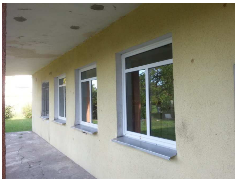
Zdj.: okna PCV w części hali sportowej
