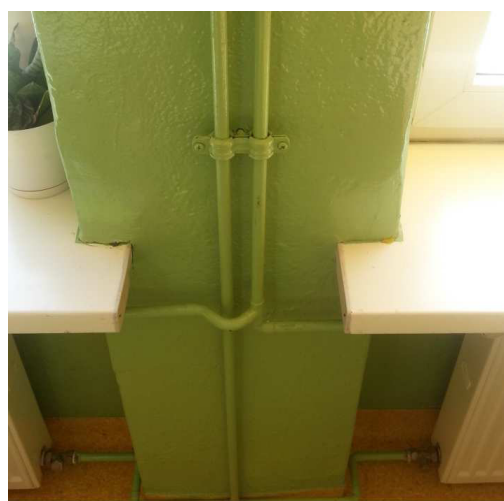
Zdj.: rozdział górny czynnika grzewczego, instalacja dwururowa.
